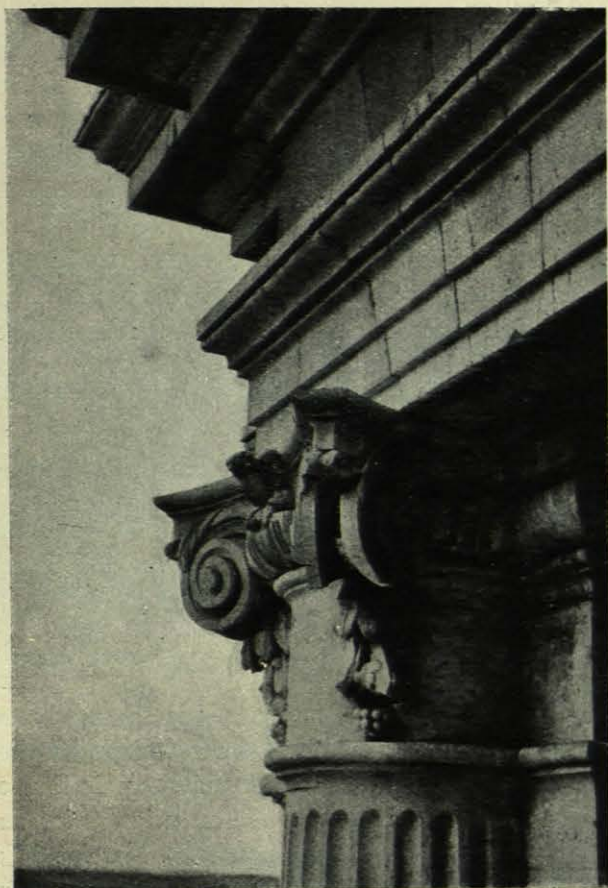
(FIG. 13). DETALLE DE CORNISAMENTO Y CAPITEL EN UN ÁNGULO DE FACHADA. Foto M. Durán.
