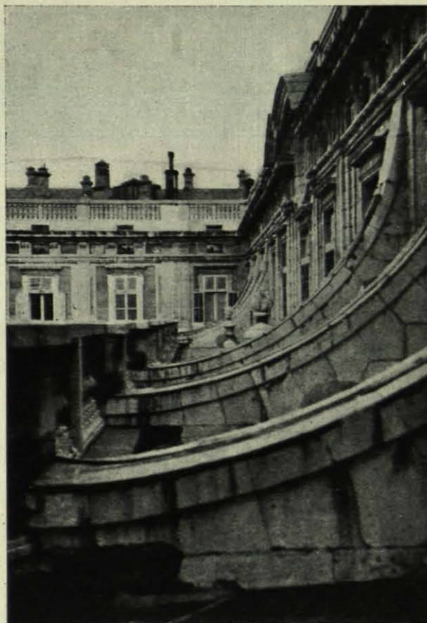
(FIG. 12). SISTEMA DE ARBOTANTES QUE DESCARGAN HACIA EL PATIO CENTRAL LAS BÓVEDAS CORRESPONDIENTES A LA GRAN ESCALERA Y SALONES DE GUARDIAS Y DE COLUMNAS.
